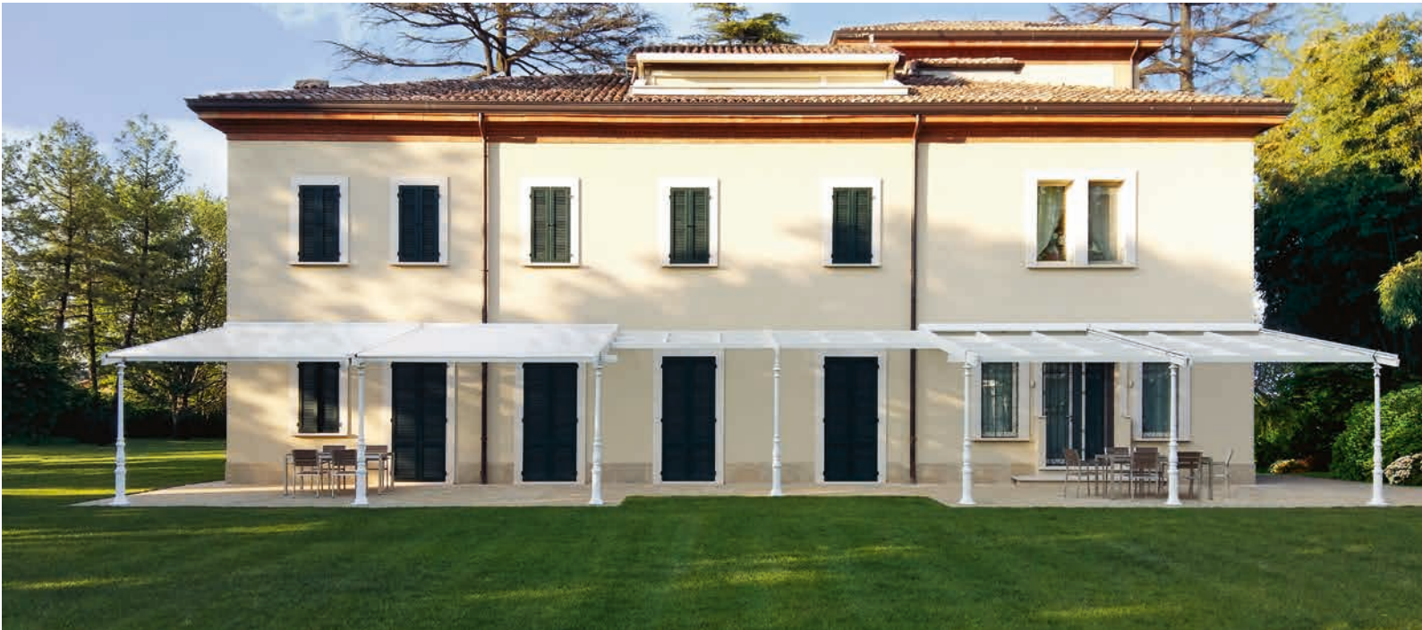
T.30 applicate su struttura metallica, realizzate con tessuto PVC impermeabile avorio e strutture di colore bianco.
